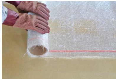
⇒ ガラスマット #450 敷設
