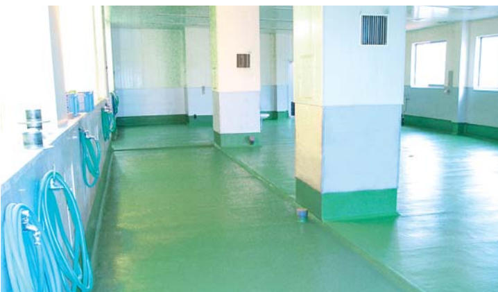
●工場床ライニング
